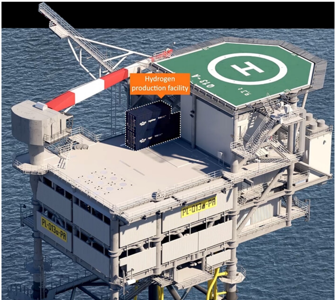
PosHYdon installatie: groene waterstof uit zeewater.
